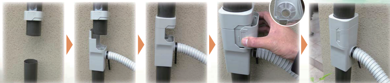
●カット後のたてどい ●継手を取付 ●継手本体の取付完了 ●ゴミ受けの取付 ●取付完了
